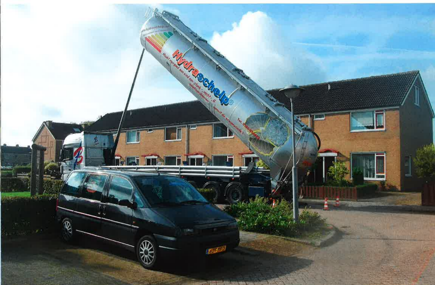
De schelpen worden aangevoerd in een tankwagen en het mengsel voor schuimbeton in silo's.
