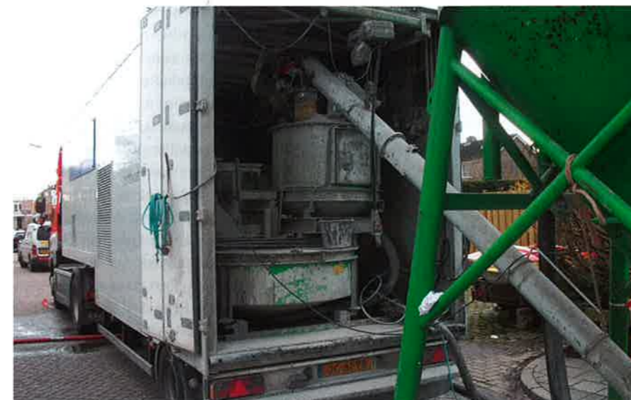
De mobiele menginstallatie voor het schuimbeton.
