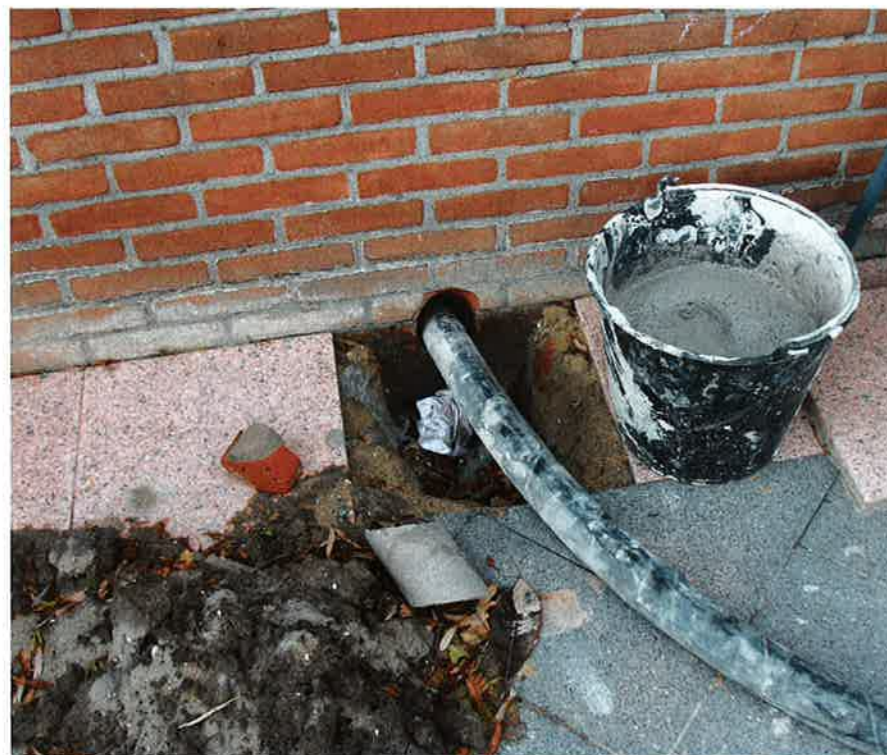
Het vullen van de kruipruimte met schuimbeton via een boorgat.
