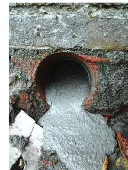
Het vullen met schuimbeton geeft nauwelijks overlast.
